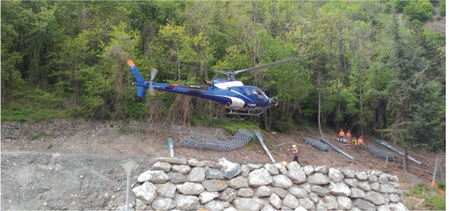
Pose de filets de protection
