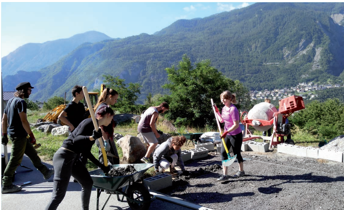
Chantier jeunes pour la construction du skate-park de Saint-Julien-Montdenis
