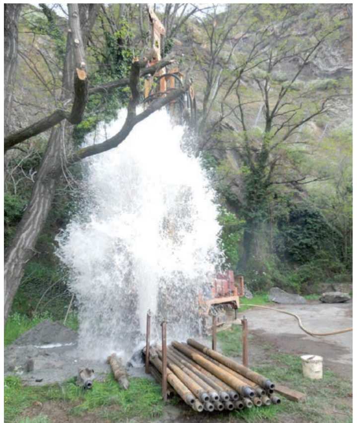
Forage de la source de l'Échaillon
