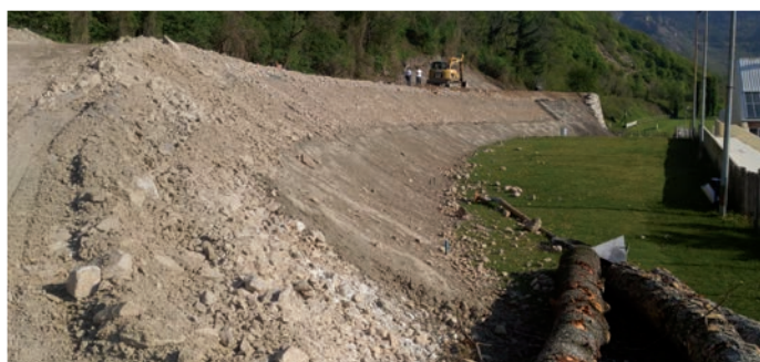
L'important remblai de matériaux pour la réalisation du merlon
