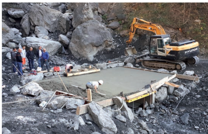
Reconstruction du radier entre les communes d'Hermillon et du Châtel
