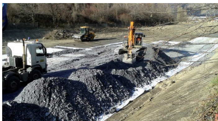
Travaux à la ZAE des Contamines
