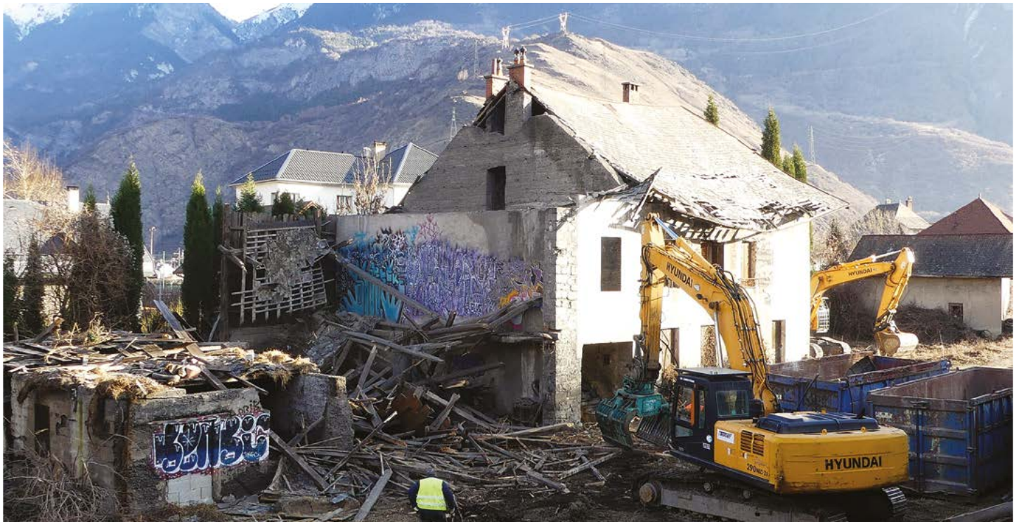
Déconstruction dans la perspective de l'aménagement de la Zone de l'Épine à Saint-Jean-de-Maurienne
