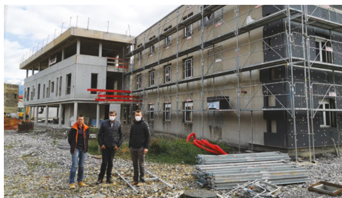
Sophie Monnois, Jean-Paul Margueron et Romaric André en visite de chantier à la Maison de l'intercommunalité
