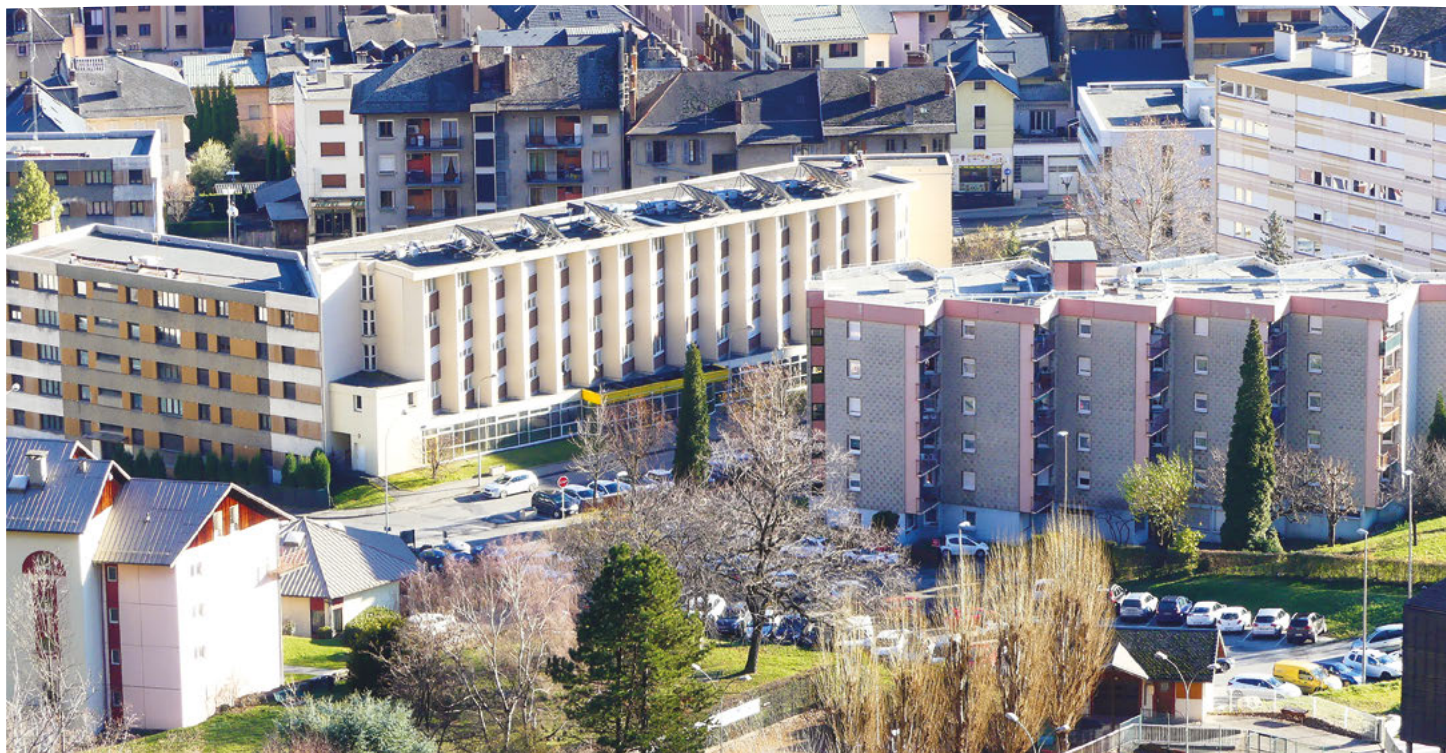
Les résidences Jean Baghe et Bonne Nouvelle à Saint-Jean-de-Maurienne
