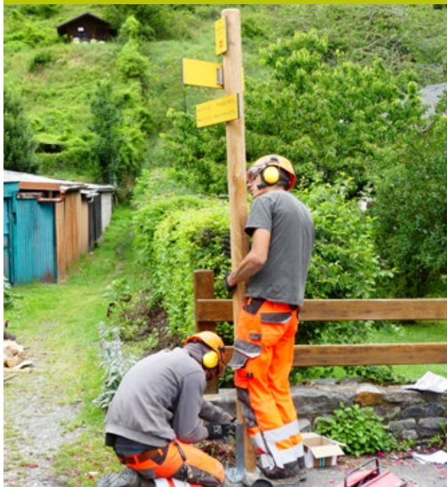
Pose de panneaux à Saint-Jean-de-Maurienne
